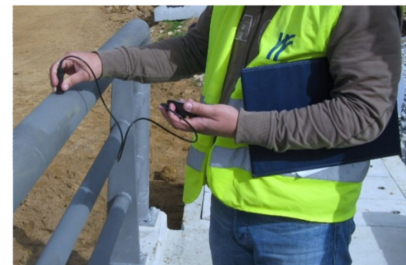
Avaliação da espessura da proteção anti corrosiva
