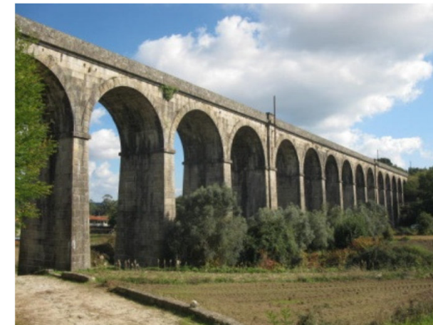
VIADUTO DE DURRÃES (1890) – LINHA DO MINHO
