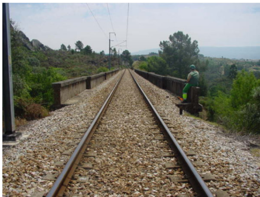
Paralelo à via (Alvenaria)
