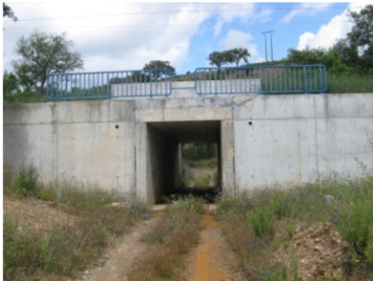
Muro de Avenida
