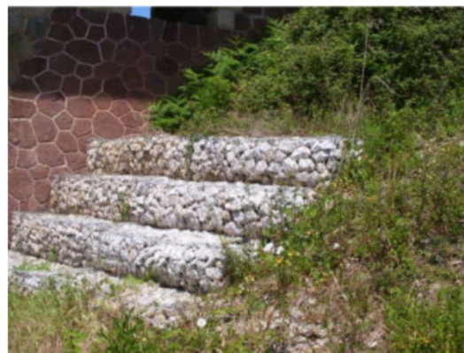
Muro de Contenção
