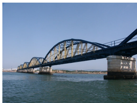
Viga Pratt (N) Parabólica
