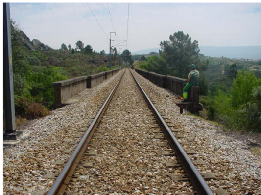
Via única balastrada
