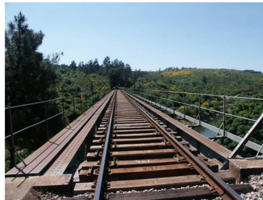
Passeios de manutenção exteriores
