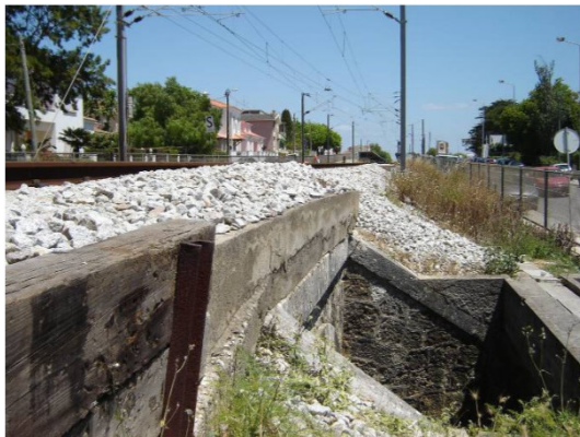
Paralelo à via (Madeira)
