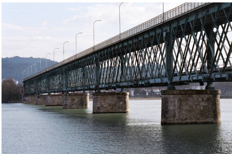
Ponte Rodoferroviária sobre o Rio Lima – Viana do Castelo
