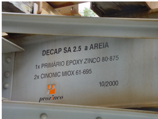
Proteção anti corrosiva de elementos metálicos
