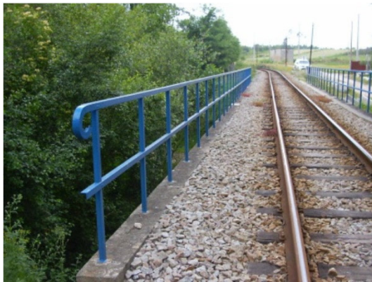
Paralelo à via (Metálicos)
