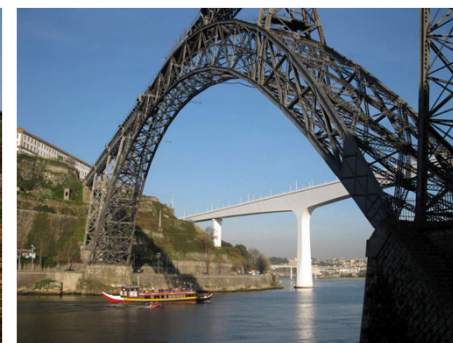
Viga em arco
