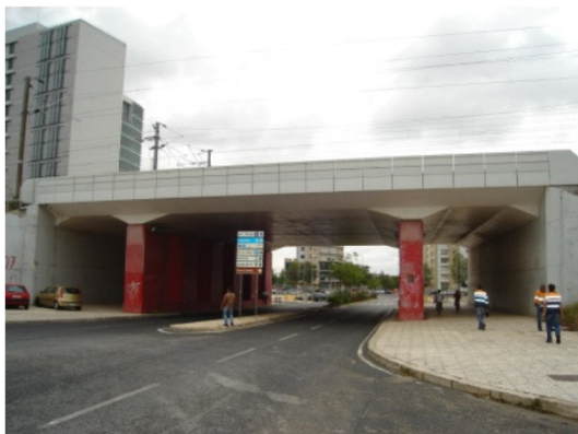
Pintura de elementos de betão
