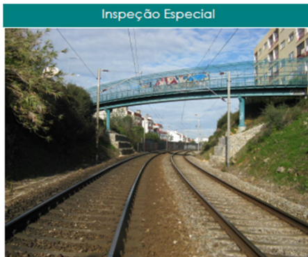
Inspeção Especial Linha do Sintra km 021,082 Passagem Superior Pedonal 08/07/2016
