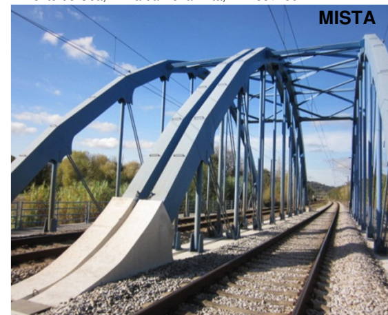
Ponte de S. Lourenço, Linha do Norte, Pk 158+662
