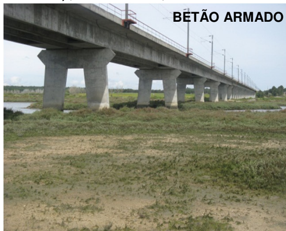
Ponte da Marateca, Linha da Sul, Pk 008+886
