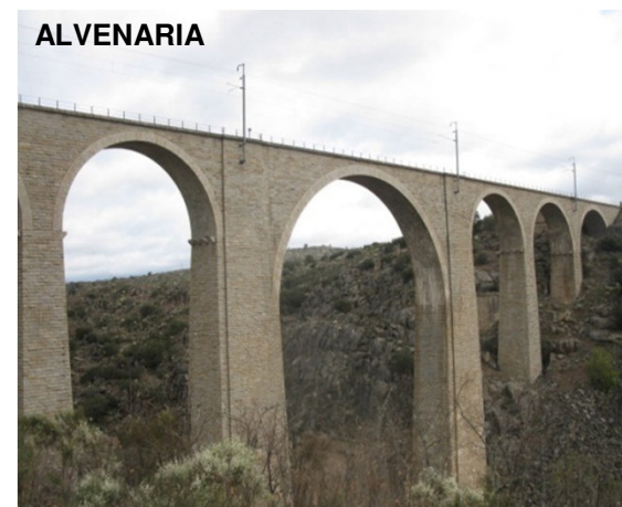
Ponte do Côa, Linha da Beira Alta, Pk 238+286
