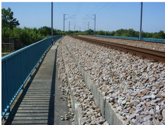
Paralelo à via (Betão armado)
